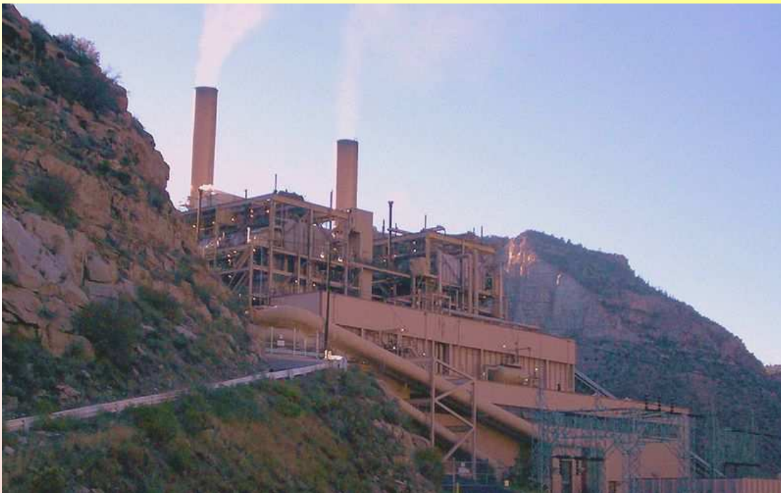
Ogļu spēkstacijas nodrošina 49 % no patērētās elektroenerģijas ASV. Castle Gate Plant, Utah.
