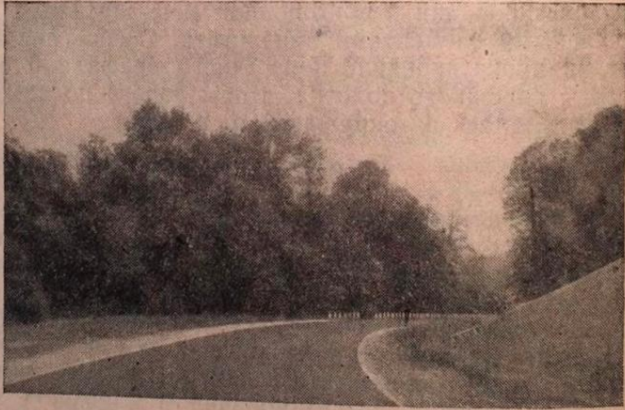
Рис. 46. Дорога с пологими округленными откосами и неглубокими кюветами овального очертания
