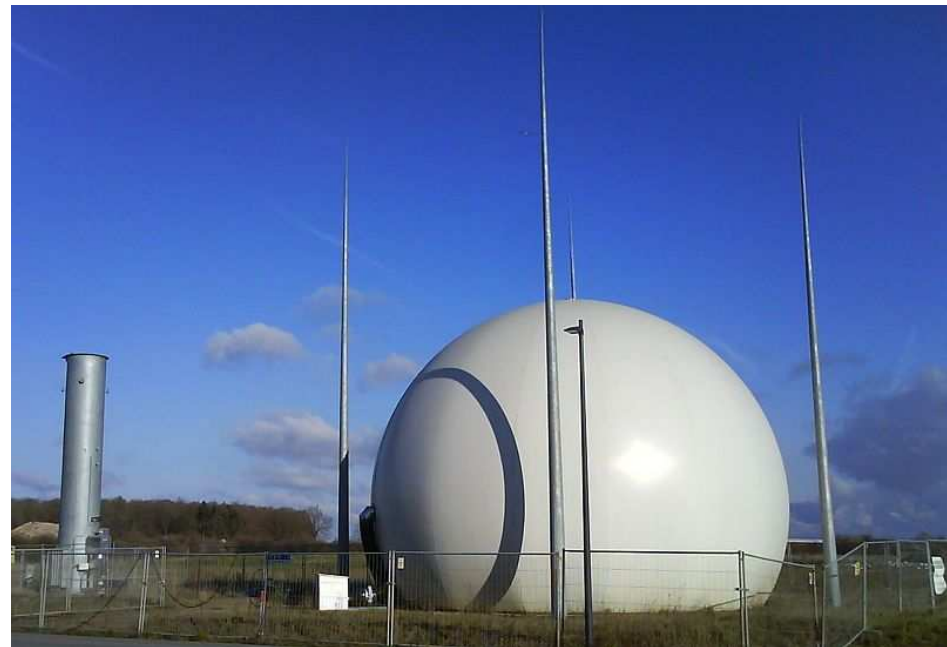
Biogāzes uzkrāšanas tvertnes, kas aprīkotas ar zibens novadītājiem
