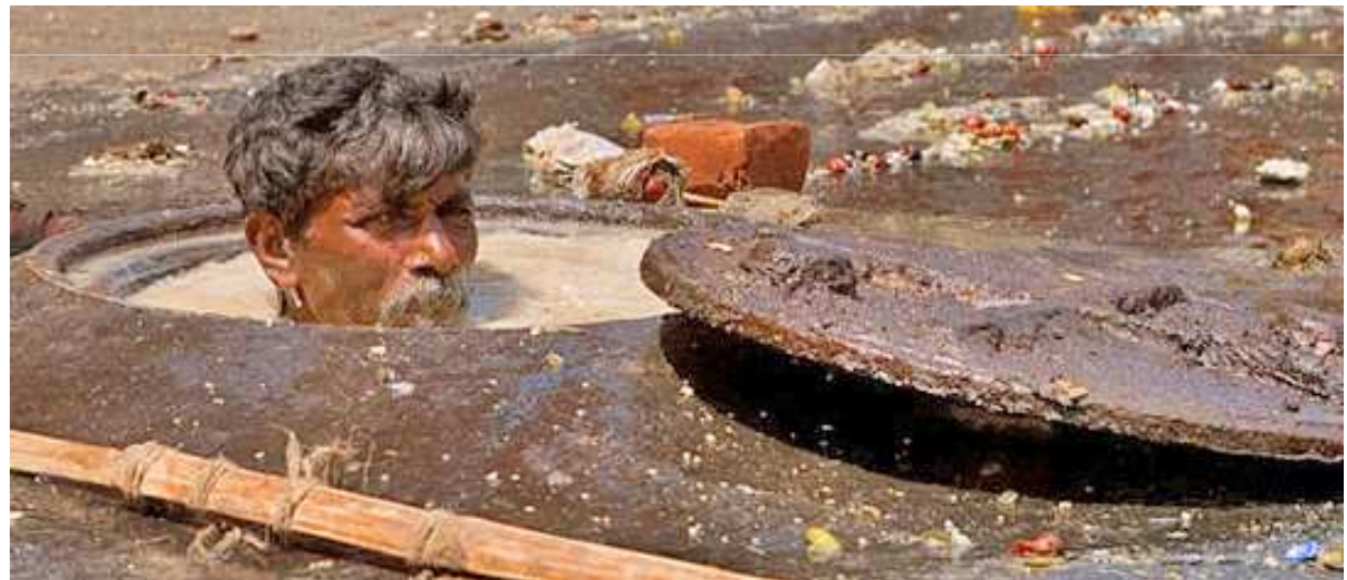
Aizsērējušas un pārplūdūšas kanalizācijas šaftas attīrīšana, Chennai, Indija
