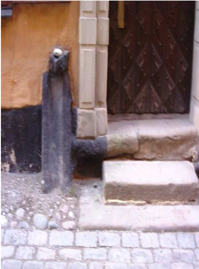
Kopš Viduslaikiem saglabājusies sadzīves notekūdeņu izliešanas vieta Stokholmas vecpilsētā. Notekūdens tika novadīts uz ielas reni, kur to aizskaloja lietus ūdeņi.
