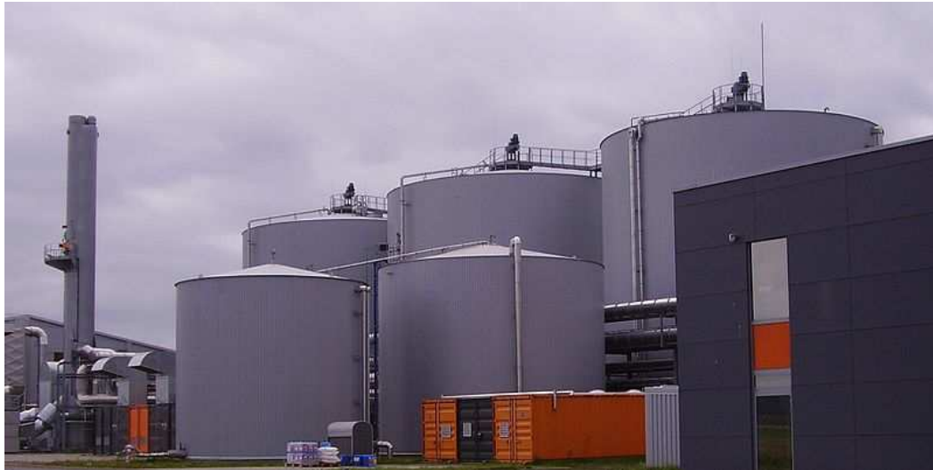
Anaerobas metāna ieguves tvertnes, Lībeka, Vācija
