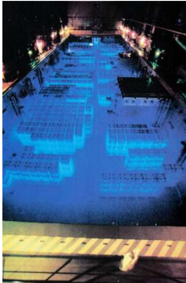
Kodolreaktora elementu izvietojums zem ūdens slāņa
